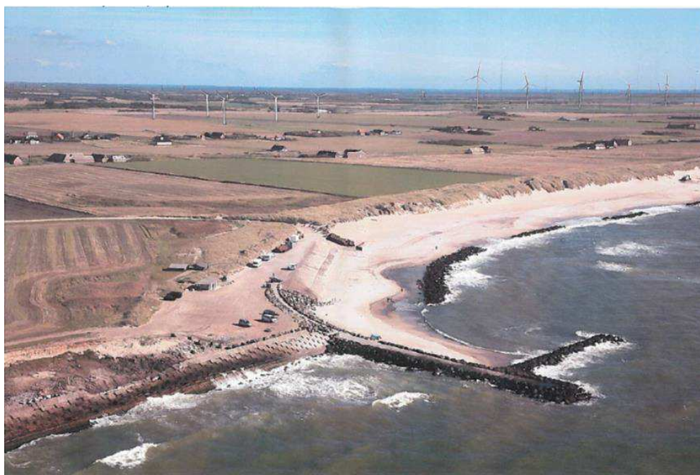
Foto 2: Kystbeskyttelse ved Fjaltring (2007/08)
