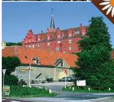
Tranekær slot - Langeland.
