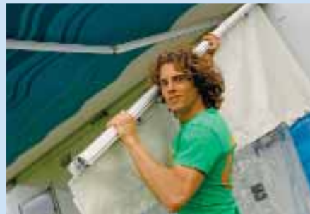
Monter profilerne mellem markise boksen og frontskinnen.
