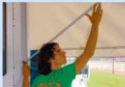
Monter diagonal stængerne til de vandrette aluprofiler samt bagstøtterne og stram til.
