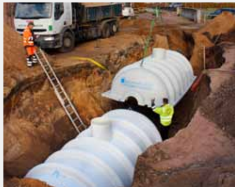
Tunnellen er nem at håndtere grundet den lave vægt
