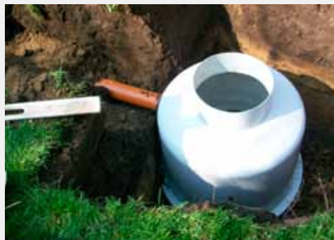
Tilslutning af kloakrør til faskinetank
