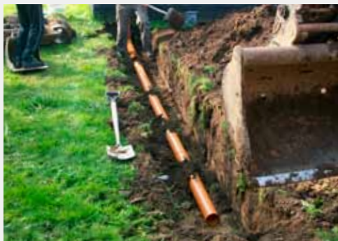
Udgravning til kloakrør og faskinetank
