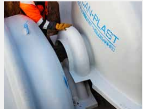
Regnvandstunnellerne samles nemt ved overfaldssammenkobling
