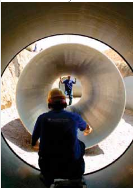
Forberedelser til samling af GAP-rør
