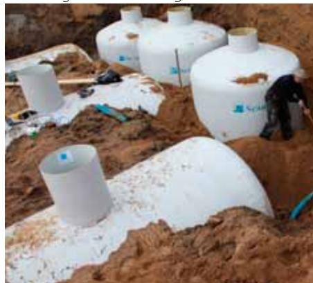
Etablering af horisontale og vertikale samletanke
