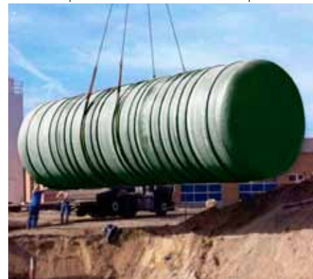
Nedhejsning af specialfremstillet samletank på 150 m 3
