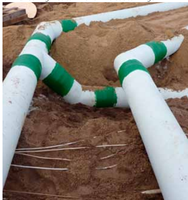
GAP-rørledning med sammenlaminerede samlinger
