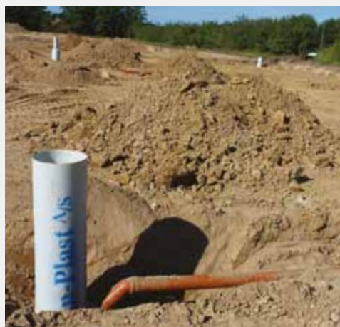
Rendestensbrønden forhøjes evt. med et forhøjerstykke og afsluttes med en støbejernsrist
