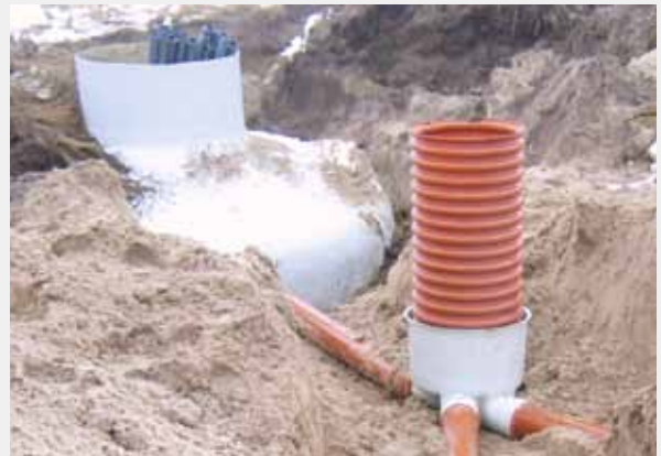
Rens- og inspektionsbrønden forhøjes med et korrugeret opføringsrør
