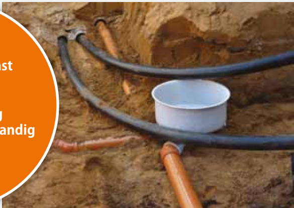
En rens- og inspektionsbrønd giver mulighed for at vedligeholde afløbssystemet uden opgravning
