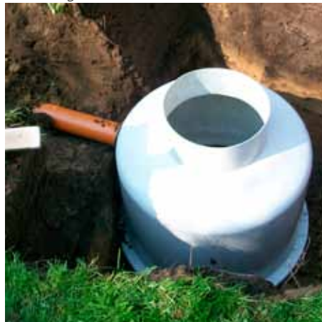
Tilslutning af kloakrør til faskinetank
