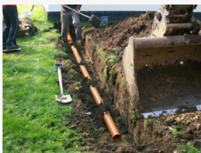
1) Săpare pentru conducte de canalizare și pentru rezervorul Fascine.
