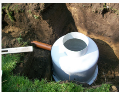
2) Racordarea conductelor de canalizare la rezervorul Fascine.
