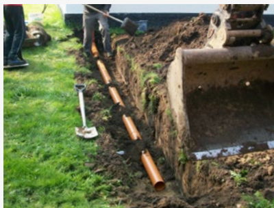
1) Udgravning til kloakrør og faskinetank.
