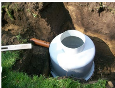
2) Montering af kloakrør på faskinetank.
