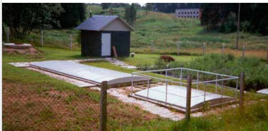
Overdækninger, der er isolerede, for at sikre en stabil driftstemperatur
