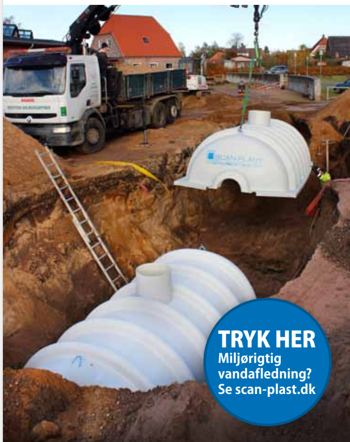
Regnvandstunnellernes lave vægt gør dem håndterbare, og modulerne kan sammenkobles til større anlæg samt dimensioneres til alle forhold
