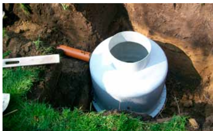
Faskinetanke giver kun fordele: Færre materialer, mindre gravearbejde og nem og simpel montage
