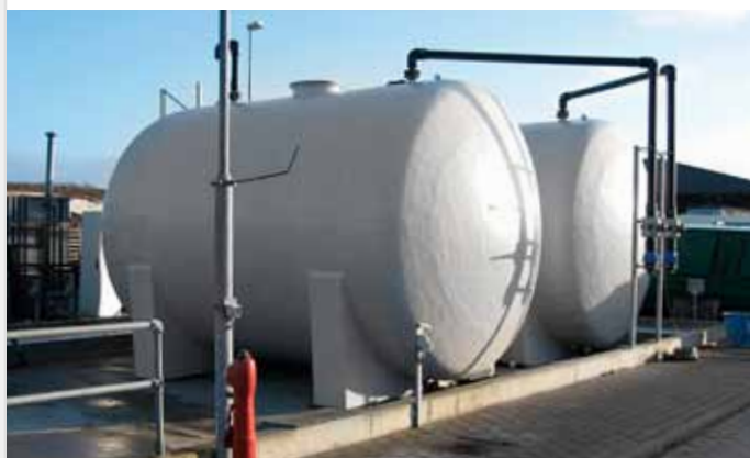
Tankanlæg til saltopløsning placeret ved Storebæltsbroen
