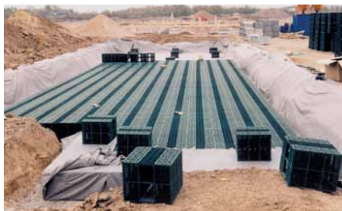
Regnvandskassetterne kan etableres både under veje med tung trafiklast og i ikke trafikerede områder
