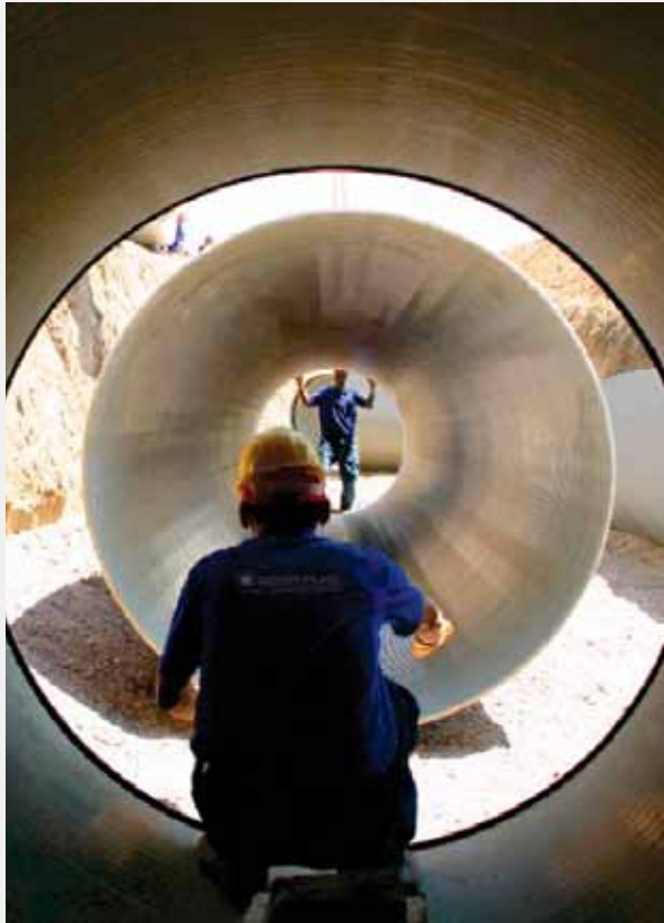
Forberedelser til samling af GAP-rør
