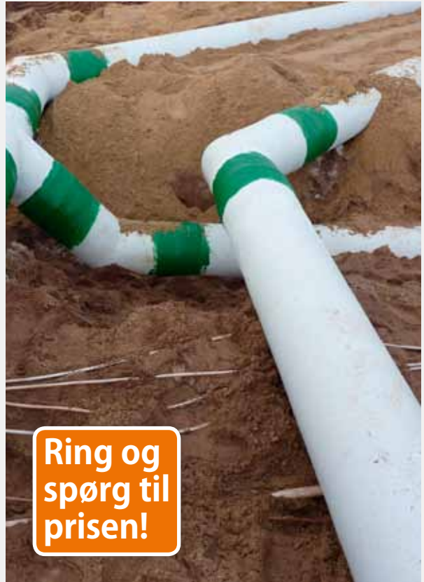
GAP-luftrørledning med sammenlaminerede samlinger
