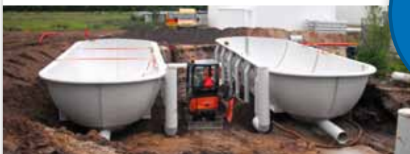
Etablering af barkfilteranlæg
