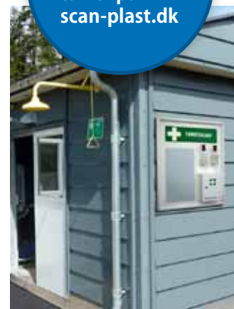
Førstehjælpstavle monteret på installationsbygning
