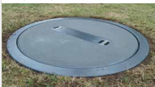
Letvægtsdæksel med fast karm lagt ned i græsplæne
