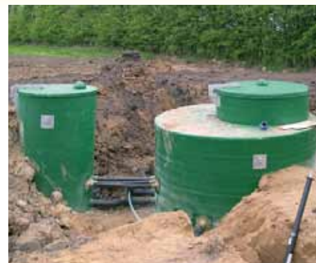
Størrelser fra Ø 400 mm til Ø 8500 mm Fremstillet i kompositmateriale, der er ca. 15 gange stærkere end PVC og PP
