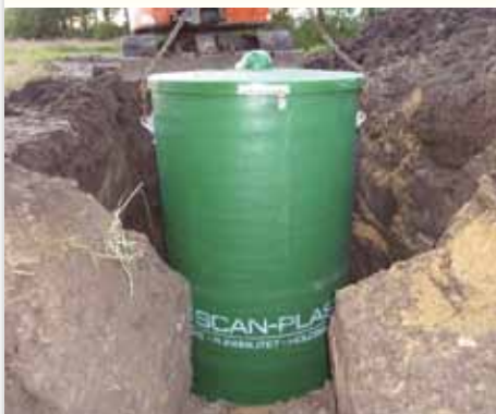
Etablering af pumpestation
