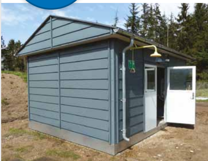
Bygning med vedligeholdelsesnem komposit klinkpladebeklædning
