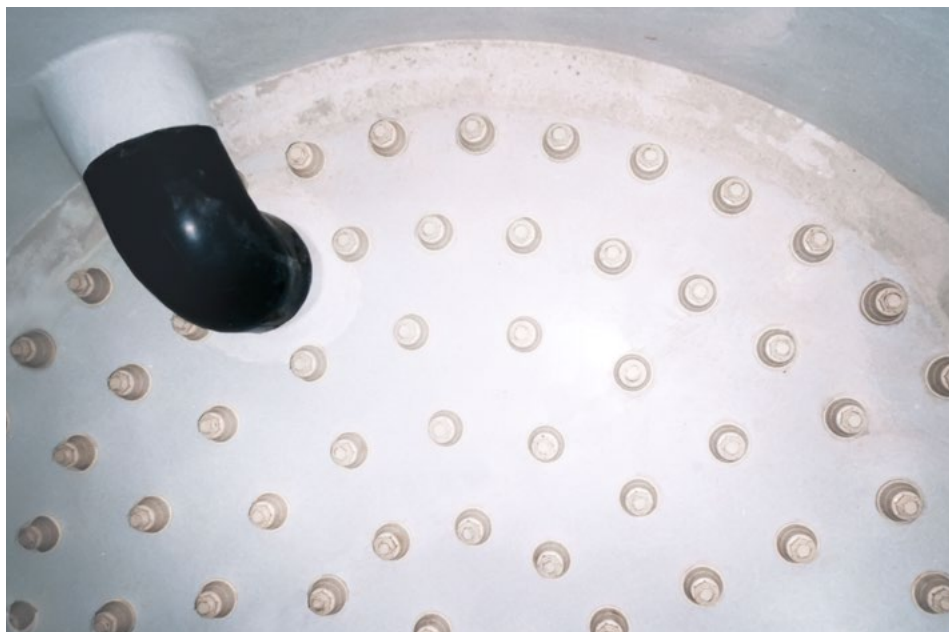
Tryk Sandfiltre er med demonterbare dyser i bunden.
