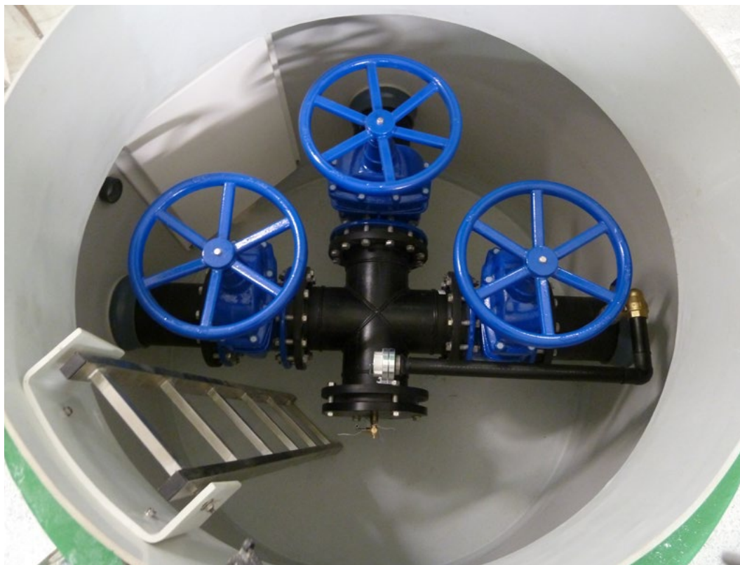
Installationsbrønd med stige og ventilarrangement.
