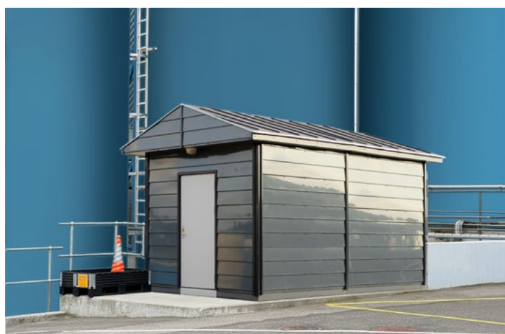
Installationsbygningen er klar til brug få timer efter levering.
