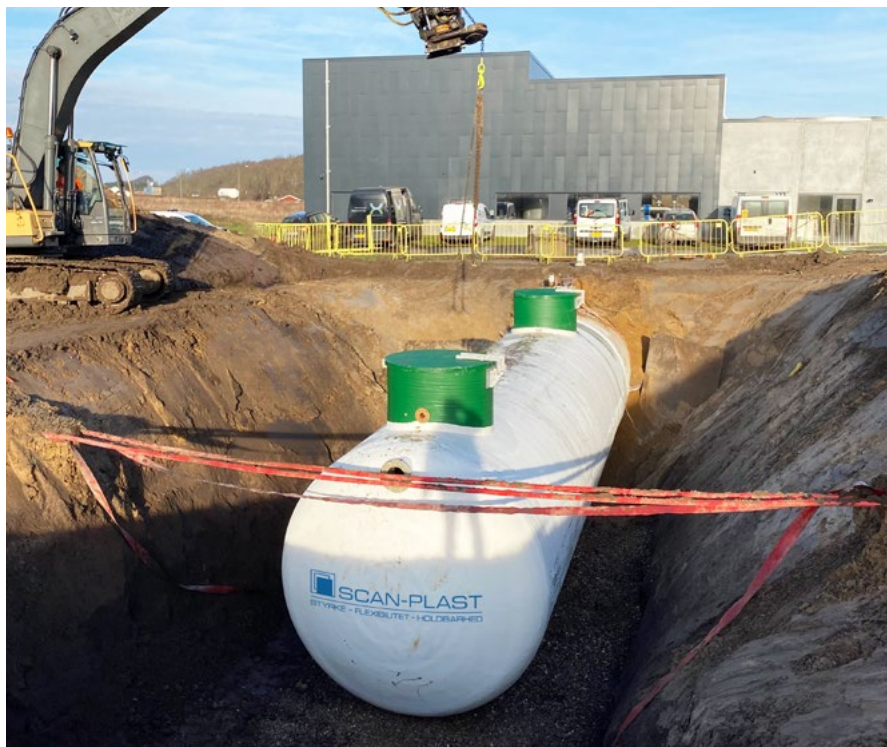
Etablering af underjordisk bundfældningstank.
