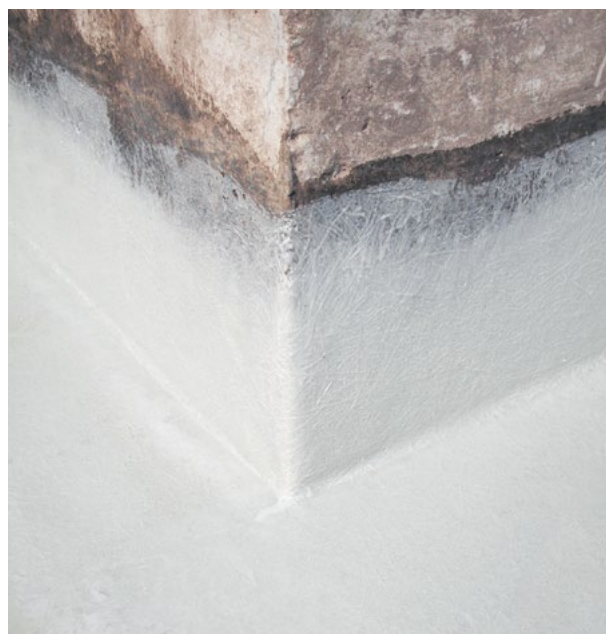
Det fiberarmerede kompositlaminat binder meget stærkt til betonfladerne.
