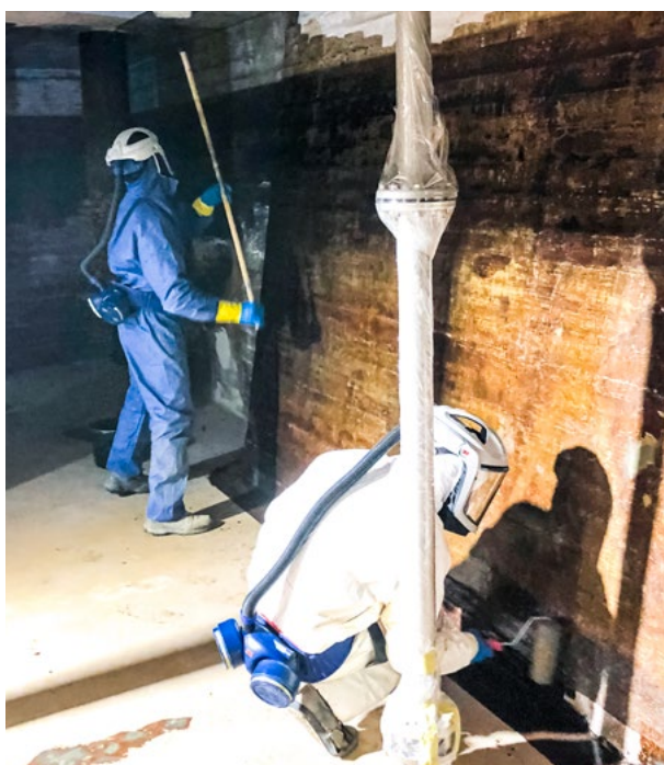
Priming påføres for at sikre en god adhæsion mellem beton og kompositlaminat.
