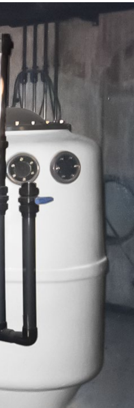
Tryk Sandfiltre er med demonterbare dyser i bunden.
