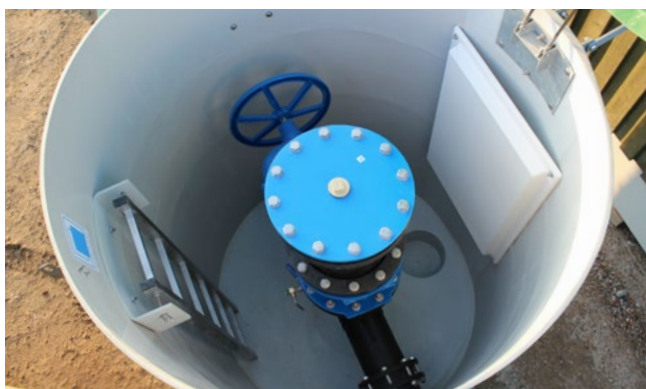
En reguleringsstation i mellemtrykzoner.
