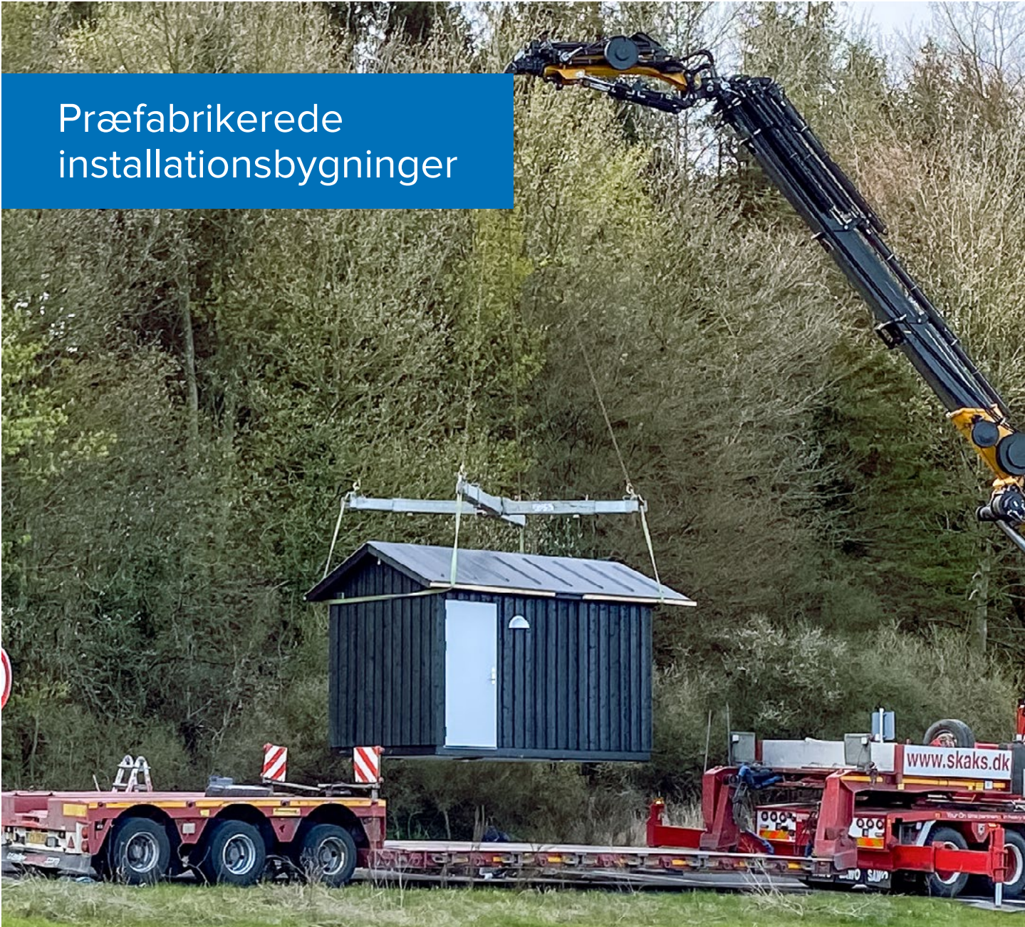
Præfabrikeret installationsbygning aflæsses.
