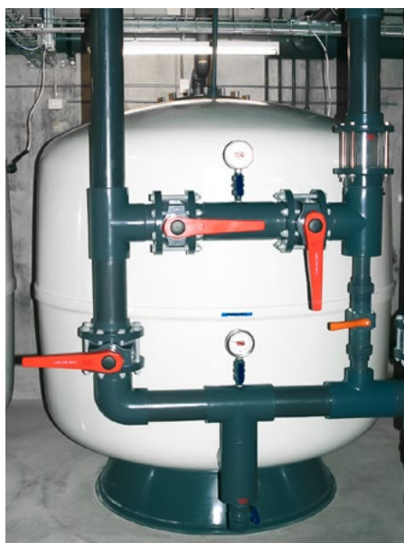
Tryk Sandfiltre er med demonterbare dyser i bunden.
