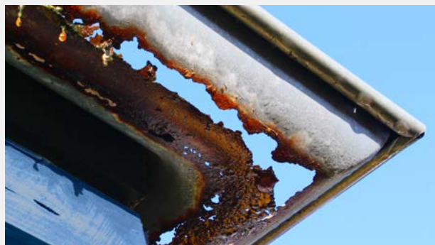
Стальной желоб, как и траншейный дренаж, подвержены химической коррозии. Композитный дренаж обладает химической стойкостью.
