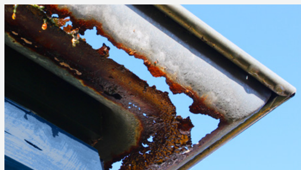
Drenajul de oțel, ca și drenajul de șanț, este supus coroziunii chimice. Drenajul compozit posedă rezistență chimică.
