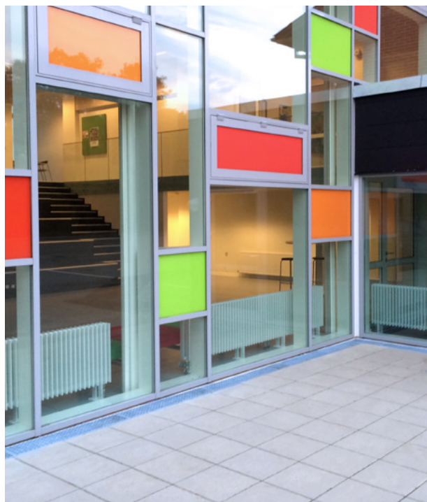
Drenajul de șanț de la Scan-Plast reprezintă ventilația și protecția optimă a fundației, precum și accesul nestingherit.
