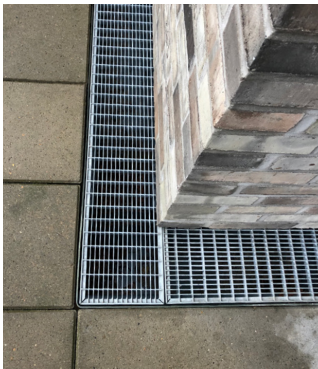
Profilele de colț prefabricate asigură o instalare ușoară fără tăiere, precum și o calitate înaltă și stabilă.
