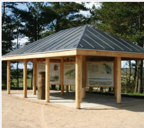
Навес с колоннадой и обшивкой козырька
