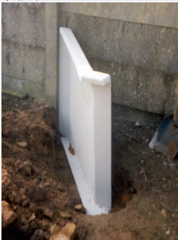
Быстрая и простая установка вспомогательного ограждения, закапывая в землю
