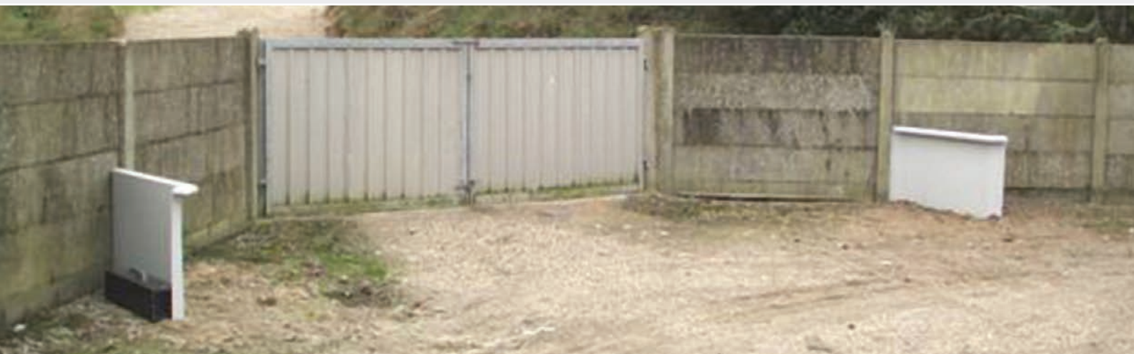
Вспомогательное ограждение установлено у ворот
