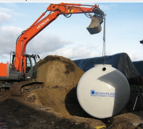
Ёмкость изготовлена из композитного материала
