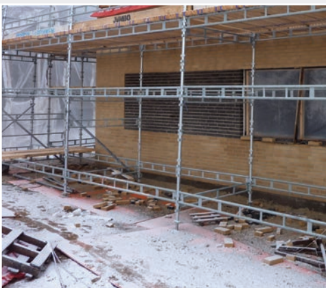
Стабильная поверхность для установки строительных лесов
