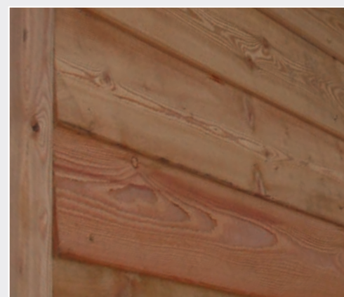
Обшивка деревянными досками
