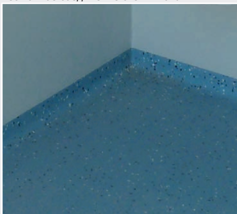
Бесшовное соединение стен и пола
