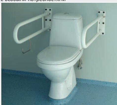
Бесшовное соединение стен и пола
