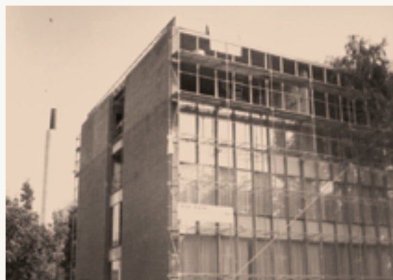
Saxogade, 1966. Ekstra etage etableres
