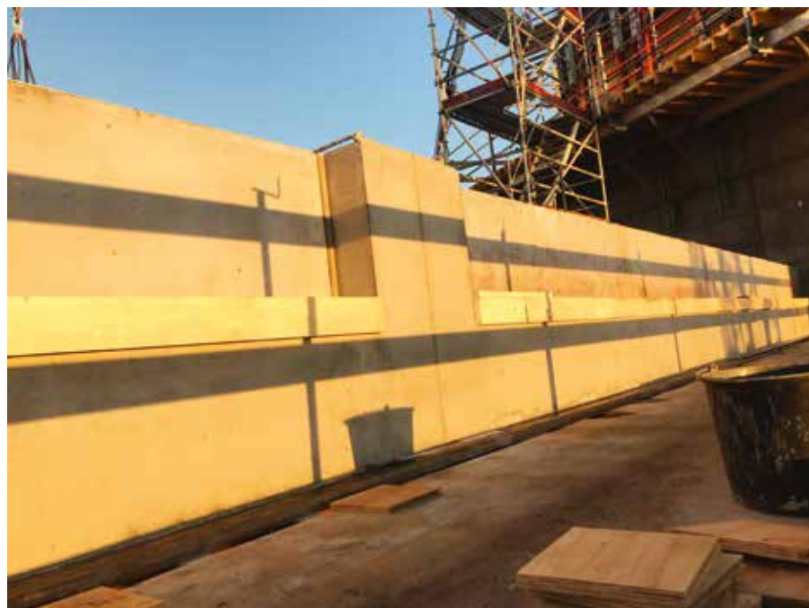
Fra byggeriet af BIG's nye hovedkontor i Københavns Nordhavn
