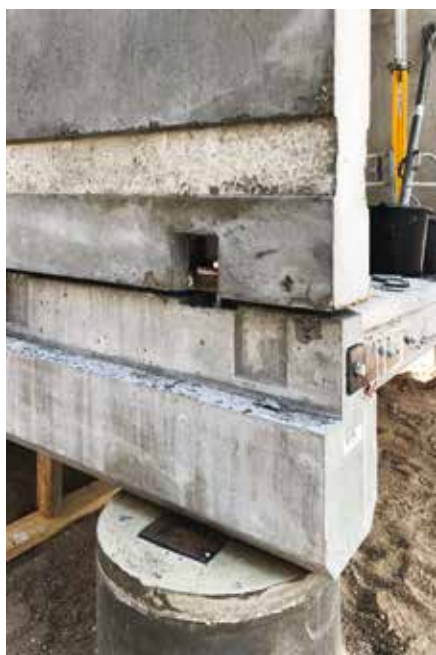
Betonelementer til design for adskillelse på Circle House
